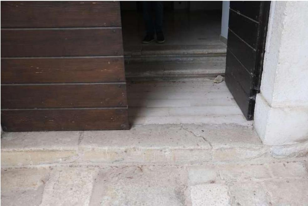
L'accesso all'auditorium presenta un dislivello pari a 3 gradini e non è al momento accessibile a persone con ridotta o impedita capacità motoria.
