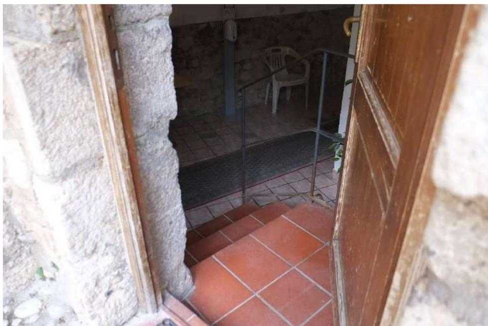
Non è presente un wc disabili; il wc esistente non è accessibile a persone con ridotta o impedita capacità motoria poiché sono presenti 3 gradini.
