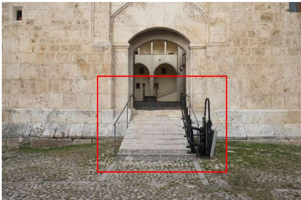
La rampa in pietra che permette l'accesso alla struttura risulta di difficile percorrenza per persone con ridotta o impedita capacità motoria. Il montascale presente non è funzionante.
