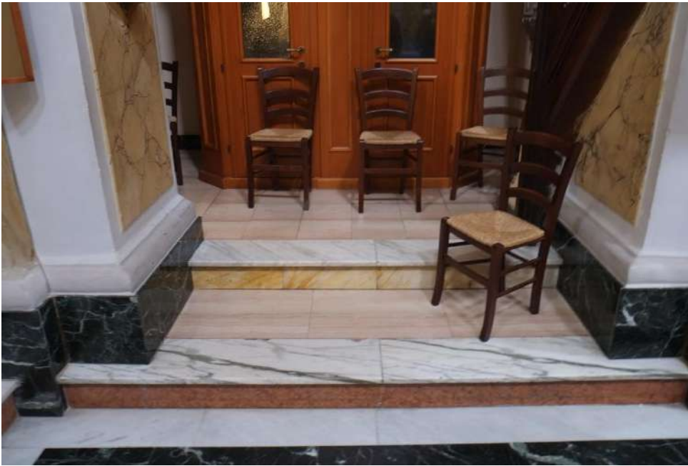
Il percorso per raggiungere l'unico wc presente (non per disabili) presenta dei gradini
